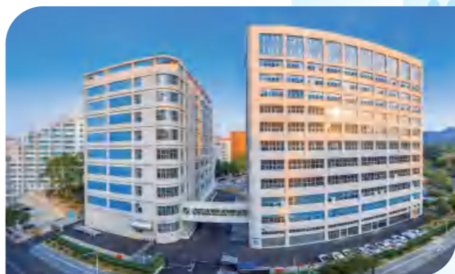
宏达通信产业园(东莞) 占地面积: 7800平方米 东莞旗峰数据中心
